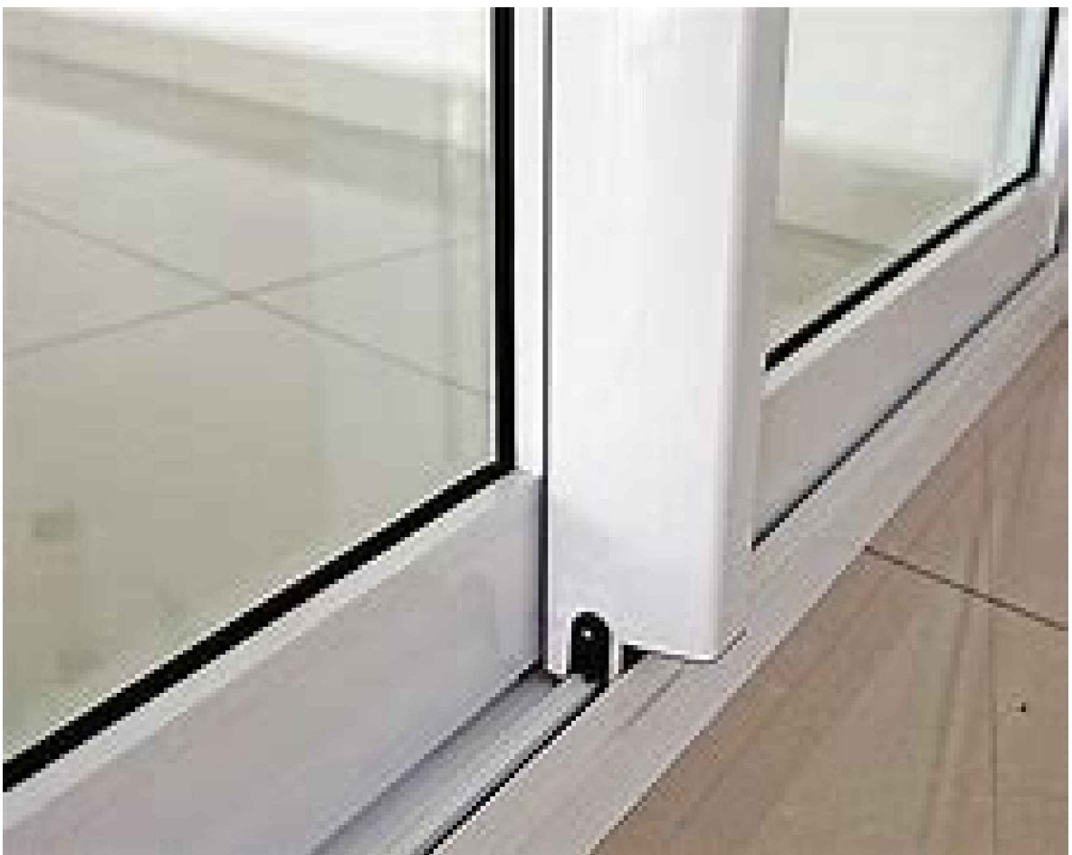
DETALHE DE TRILHO PARA PORTA DE CORREIO
